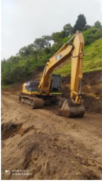
Excavadora Caterpillar 320BL
